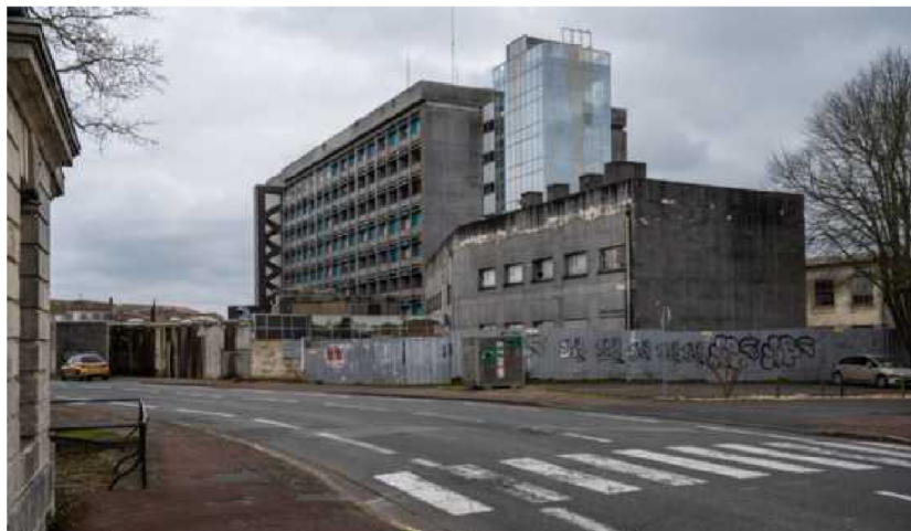
Tous les bâtiments autour de la barre signée de l'architecte Marc Quentin seront démolis en septembre 2022. XAVIER LÉOTY/SUD OUEST
